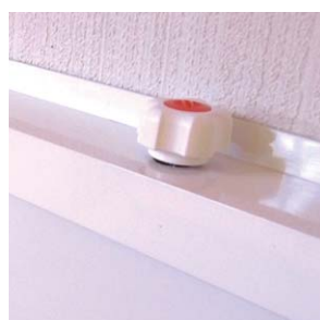
ヘッドレールとパネルの 固定用ボルト・ナット
