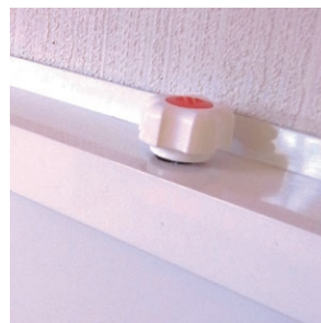
ヘッドレールとパネルの 固定用ボルトノブ
