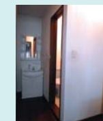
トイレ改修前
