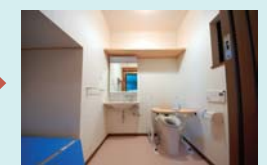
トイレ改修後
